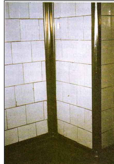
Figura 5 - Paraspigoli in acciaio, ben installato.
