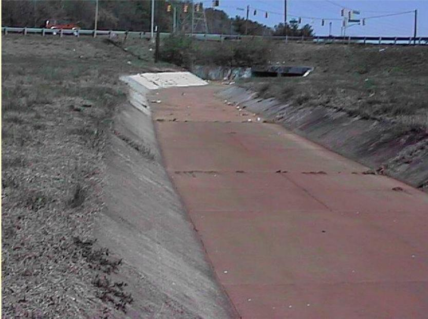
Canali a sezione trapezoidale con rivestimento in cemento
