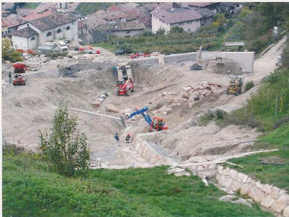
Fig. 12 – Panoramica dei lavori di realizzazione del bacino di deposito, presidiato da una briglia selettiva con terrapieni di protezione e mascheramento (settembre 2002)
