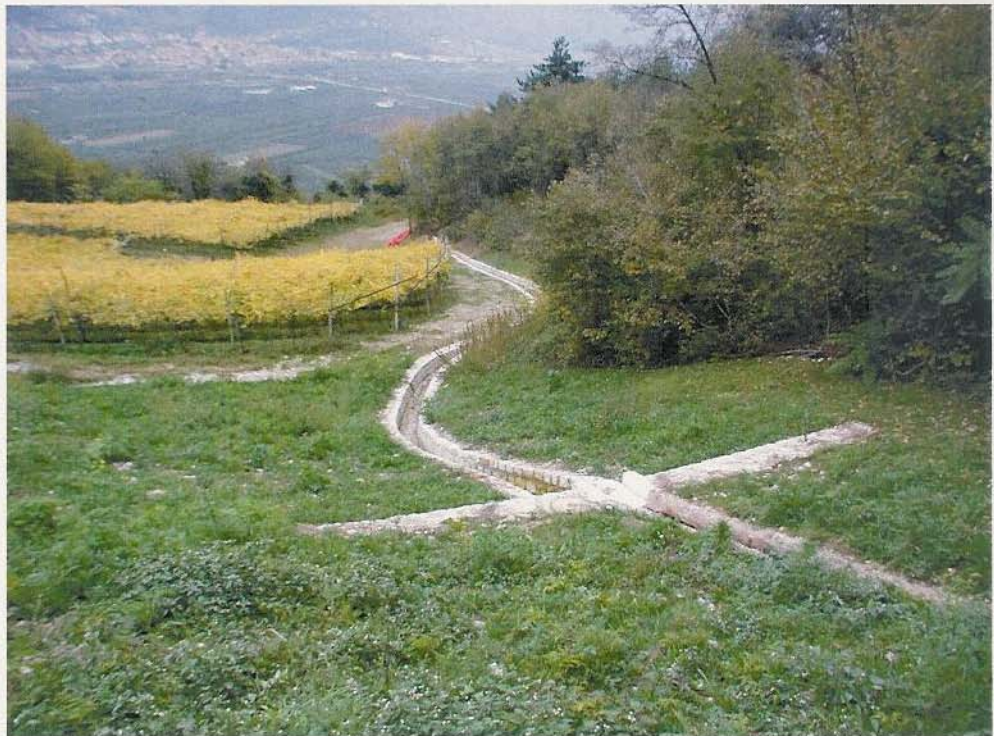
Fig. 13 e 14 – Le opere di sostegno e consolidamento, collegate da una canaletta in legname, realizzate nella vallecchia di Maso Maset, sopra la Limonara. Tutta l'area è stata drenata ed i deflussi sono stati convogliati con tubazioni in PE fino alla sottostante canaletta in pietrame e calcestruzzo (settembre-ottobre 2002)
