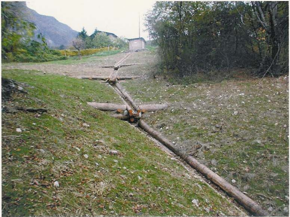
Fig. 13 e 14 – Le opere di sostegno e consolidamento, collegate da una canaletta in legname, realizzate nella vallecchia di Maso Maset, sopra la Limonara. Tutta l'area è stata drenata ed i deflussi sono stati convogliati con tubazioni in PE fino alla sottostante canaletta in pietrame e calcestruzzo (settembre-ottobre 2002)
