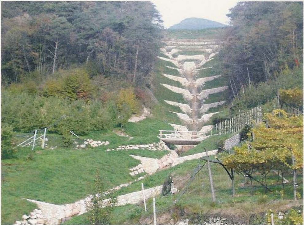
Fig. 16 – I lavori sulla parte centro-superiore della vallecola e sulla testata del franamento sul Rio Prà dell'Acqua dopo tre mesi dalla conclusione delle operazioni di rivegetazione dei terreni (ottobre 2002)
