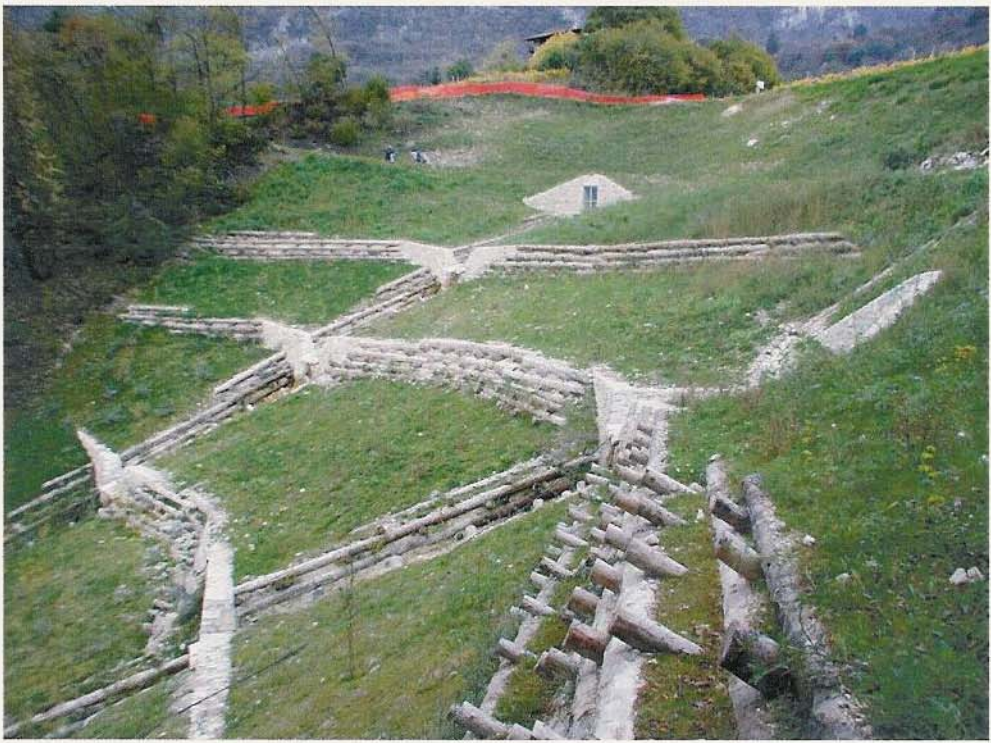
Fig. 15 – Panoramica dei lavori eseguiti alla testata del Rio Prà dell'Acqua: in primo piano le due canalizzazioni intervallate dalle opere di consolidamento e sostegno in pietrame e calcestruzzo o in legname. Sullo sfondo la galleria drenante che capta le acque della sorgente superiore, sulla sponda destra della frana (settembre 2002)
