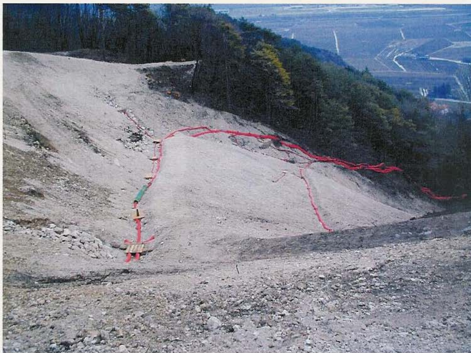
Fig. 7 – Con gli interventi di somma urgenza è stata rimodellata la corona dello smottamento e sono state provvisoriamente captate tutte le venute d'acqua presenti nel corpo franoso del Prà dell'Acqua (dicembre 2000).
