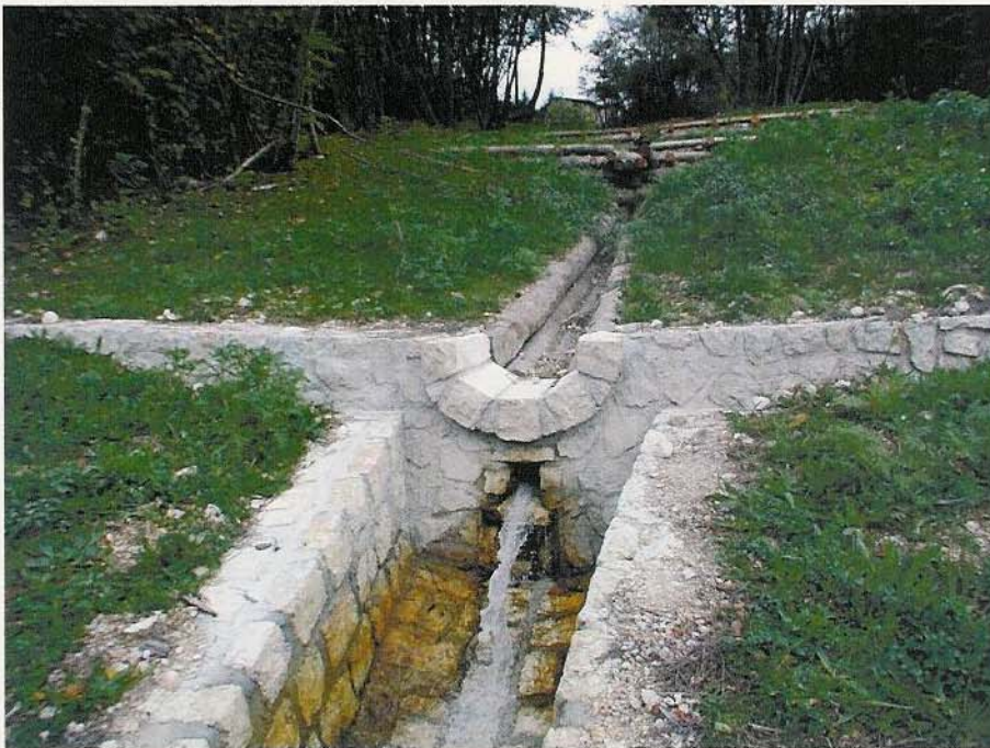
Fig. 17 – I lavori sulla parte centro-superiore della vallecola sopra la Limonara: in primo piano il raccordo fra le opere in legname ed i manufatti in pietrame e calcestruzzo, con il punto di scarico delle acque provenienti dai drenaggi e dalle sorgenti presenti a valle di Maso Maset, a due mesi dagli interventi di rivegetazione dei terreni (ottobre 2002)
