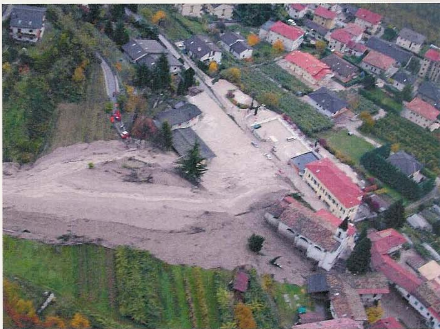
Fig. 3 – la colata di fango ha investito la chiesa con la canonica, l’oratorio e l’edificio scolastico.
