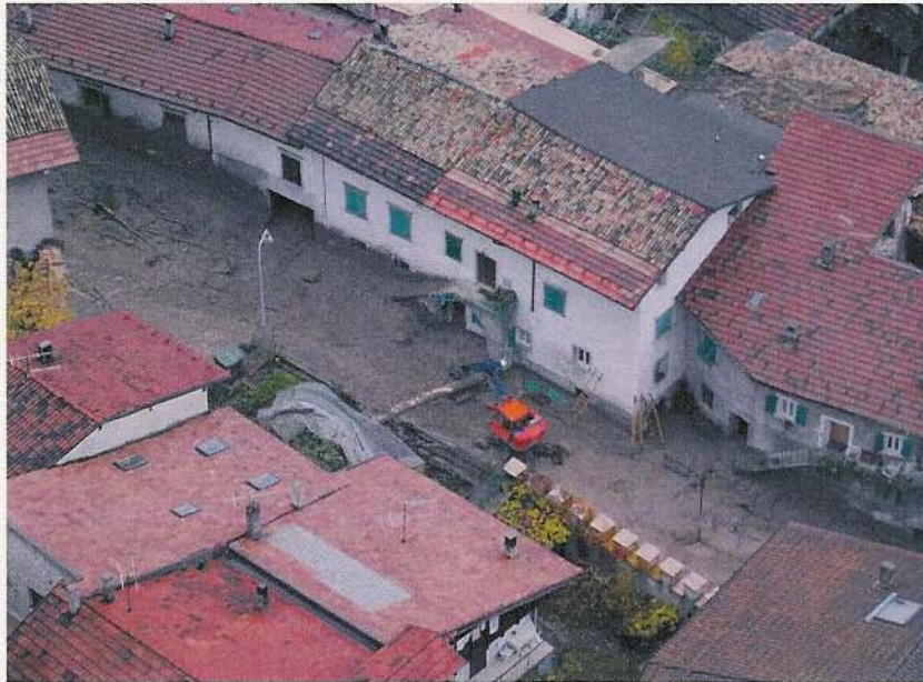
Fig. 4 - Il “fiume di fango” si è incanalato lungo via Santa Brigida, la strada principale dell’abitato.
