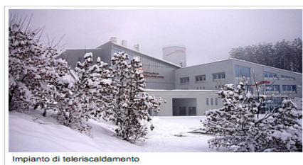
Impianto di teleriscaldamento
