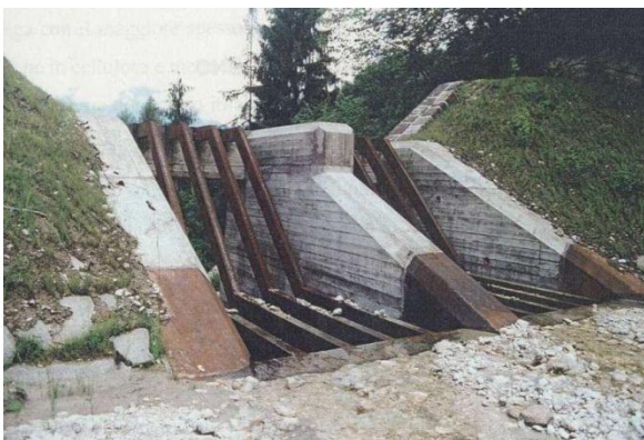
Fig. 19 – Briglia selettiva con filtro ad inclinazione multipla nel Rio Fumola (Tn)
