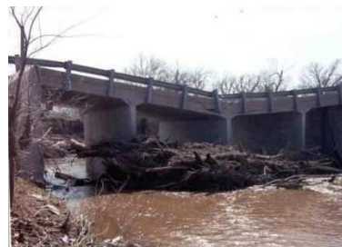
Fig. 7 – Tronchi accumulati a monte di un ponte hanno causato la rottura (fonte: Bradley et al., 2005)
