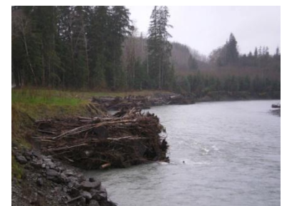
Fig. 23 – Difesa di una sponda in erosione attraverso ceppaie e tronchi legati con catene
