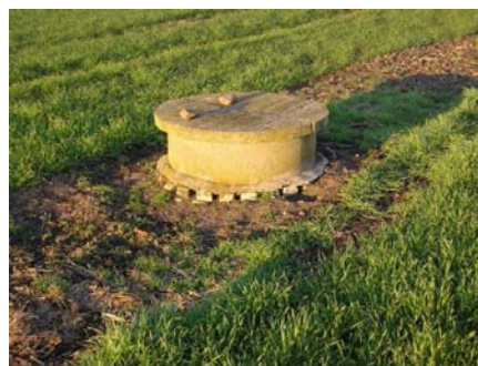
Fig. 108 – Esempio di pozzo correttamente coperto.
