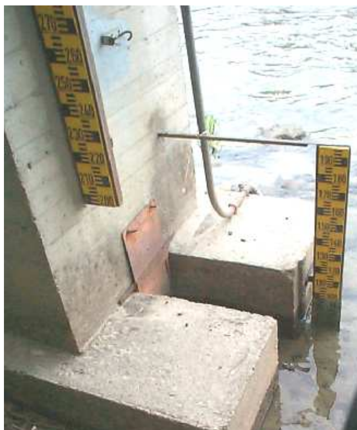
Foto 1 – Asta idrometrica di Barziza
