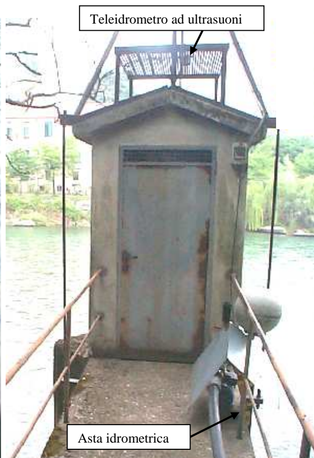
Foto 2 – Capannina idrometrografica di Barziza
