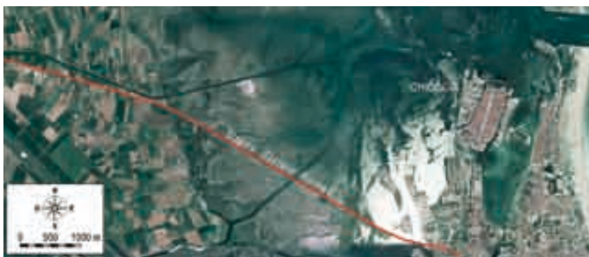
Fig. 5.5 - Il tracciato della nuova Strada Statale Romea che taglia la laguna nel bacino di Chioggia.
